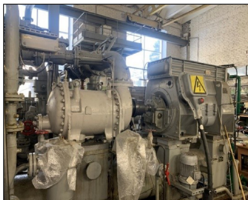
Рис. 2. Установка переходных пластин гелиевого винтового компрессорного агрегата «Каскад-80/25» № 1 под компрессор и электродвигатель
